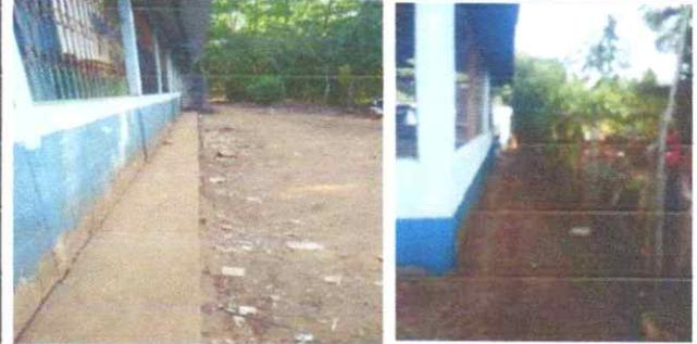
Sustitución de muro perimetral con block y columnas cada dos metros
