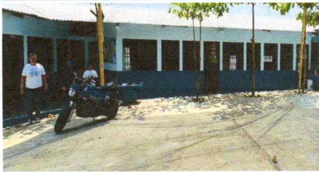
Sustitución de bajada de agua pluvial de metal por tubo PVC 3"
