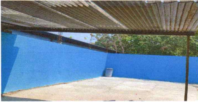
Sustitución de lamina zinc por lamina Maxalum troquelada calibre 26
