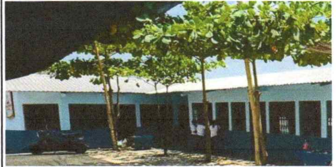
Sustitución de canal de metal
