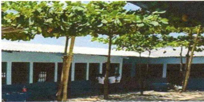
Sustitución de canal de metal
