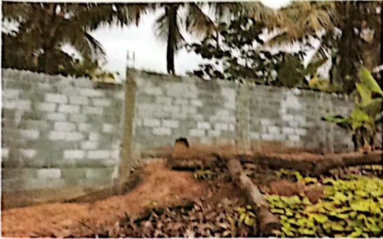
Foto 1: Suministro y sustitución de muro perimetral
