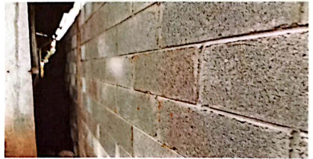
Foto 4: Suministro y sustitución de muro perimetral
