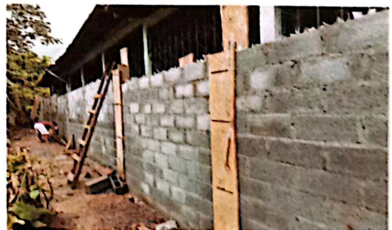
Foto 6: Suministro y sustitución de muro perimetral
