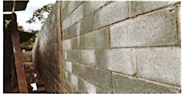
Foto 2: Suministro y sustitución de muro perimetral
