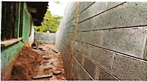
Foto 3: Suministro y sustitución de muro perimetral
