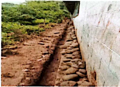
Foto 3: Suministro y sustitución de muro perimetral
