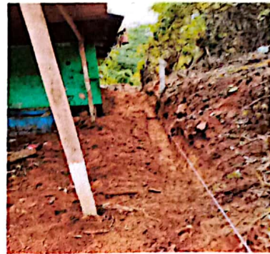
Foto 4: Suministro y sustitución de muro perimetral
