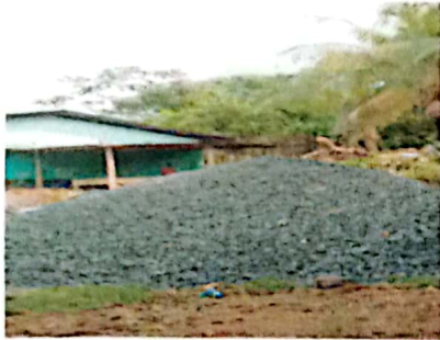
Foto 1: Suministro y sustitución de muro perimetral
