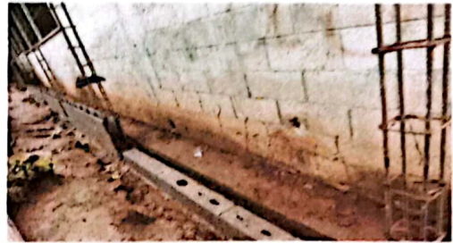
Foto 2: Suministro y sustitución de muro perimetral
