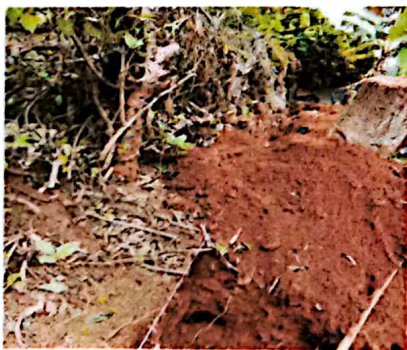
Foto 5: Suministro y sustitución de muro perimetral
