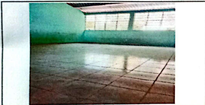
Foto 3: Sustrucción piso cerámico
