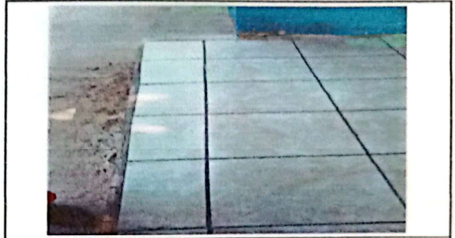
Foto 2: Sustrucción piso cerámico
