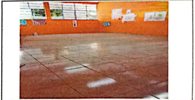
Foto 4: Sustrucción piso cerámico
