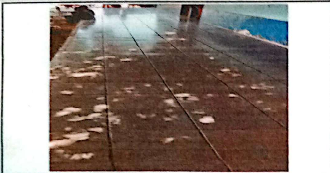
Foto 1: Sustrucción piso cerámico
