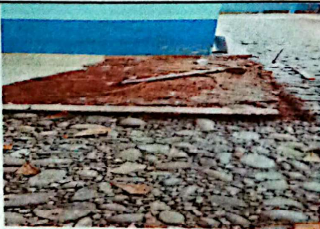
Foto 5: Sustitución piso cerámico
