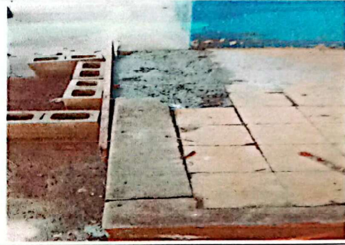
Foto 2: Sustitución piso cerámico
