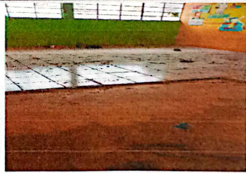
Foto 4: Sustitución piso cerámico
