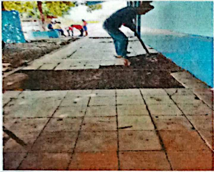
Foto1: Sustitución piso cerámico
