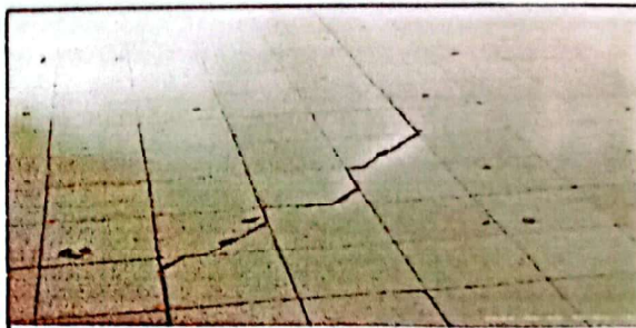
Foto 4: SUSTITUCION PISO CERAMICO /
