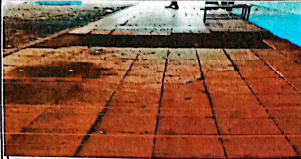
Foto 1: SUSTITUCION PISO CERAMICO /
