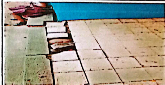
Foto 2: SUSTITUCION PISO CERAMICO /
