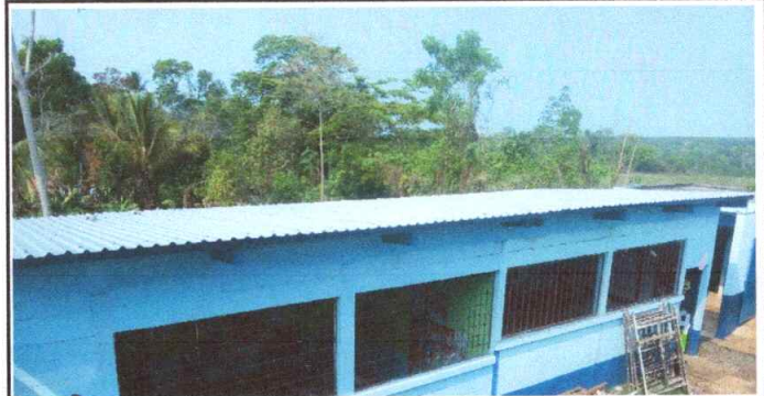
Foto 2: VISTA DE INSTALACIÓN DE LÁMINA FINALIZADO
