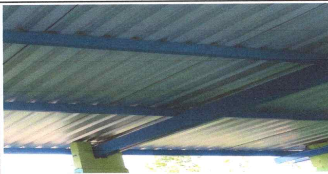
Foto 3: VISTA INTERIOR ESTRUCTURA GALVANIZADA
