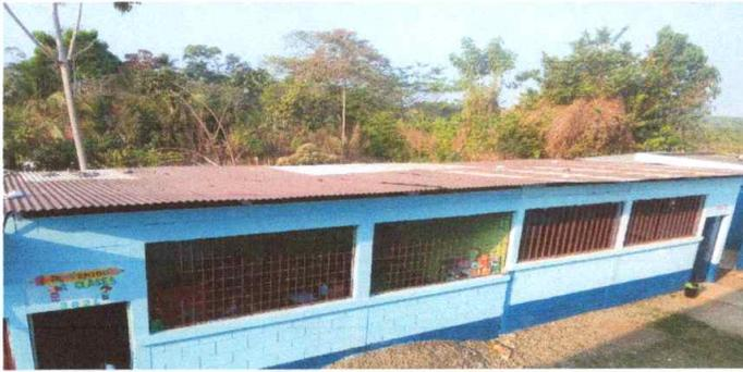
Foto 1: VISTA TECHO CON LAMINA DETERIORADA
