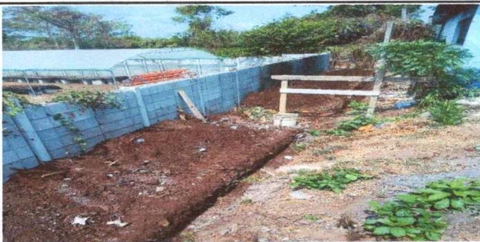
Foto 5: VISTA DE SUSTITUCION DE MURO PERIMETRAL Y CUNETAS DE CONCRETO
