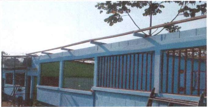
Foto 4: VISTA CAMBIO DE ESTRUCTURA PORTANTE DE MADERA POR COSTANERAS GALVANIZADAS CALIBRE 26
