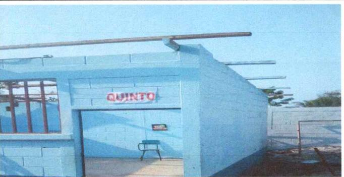
Foto 3: VISTA CAMBIO ESTRUCTURA PORTANTE DE MADERA POR COSTANERAS GALVANIZADAS CALIBRE 26
