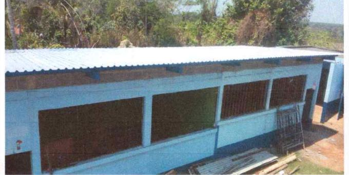
Foto 2: VISTA DE INSTALACIÓN DE LÁMINA TROQUELADA CALIBRE 26
