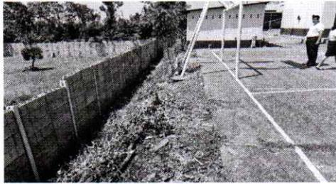
Sustitucion de estructura portante de madera por costaneras galvaizadas ,
