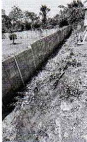
Sustitucion de lamina acanalada por lamina troquelada calibre 26
