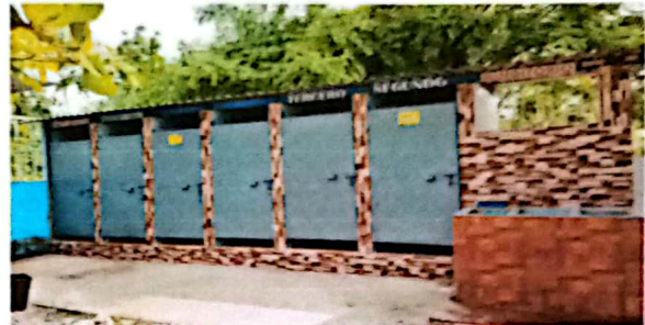
SUSTITUCION DE PUERTAS METALICAS DE SERVICIOS SANITARIOS
