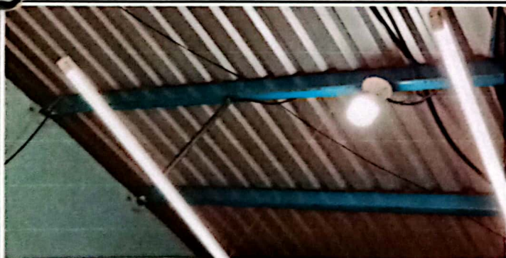
MANTENIMIENTO A SISTEMA ELECTRICO
