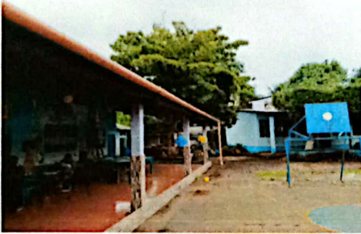
SUSTITUCION DE CANALES DE BAJADA DE AGUA PLUVIAL
