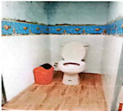
SUSTITUCION DE INODORO
