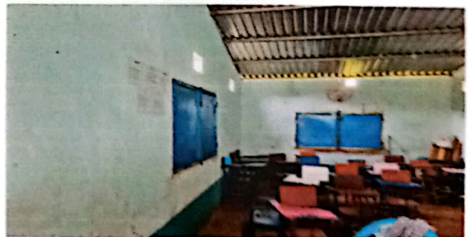
SUSTITUCION DE VENTANAS
