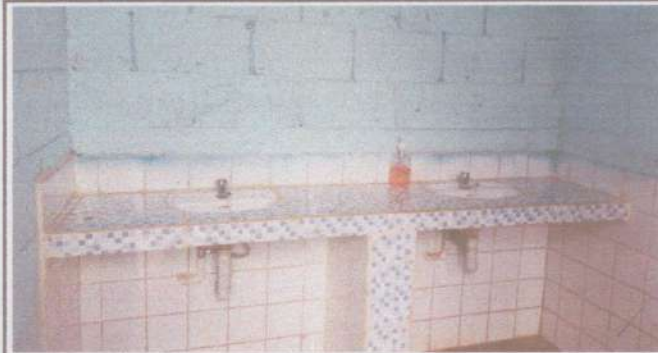
Foto 7: Sustrucción de mezcladora lavamanos (llave, contra llave, tubo de abasto). FINALIZADO.
