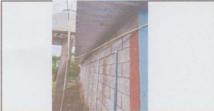
Foto 9: Sustrucción de tubería PVC 1/2 Y 3/4 línea principal. FINALIZADO.
