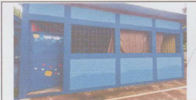
Foto 5: Sustitución de chapa cerradura sobreponer de engrape. FINALIZADO.
