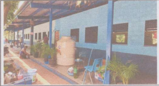
Foto 14: Aplicación pintura exterior latex celeste y pintura aceite azul.
