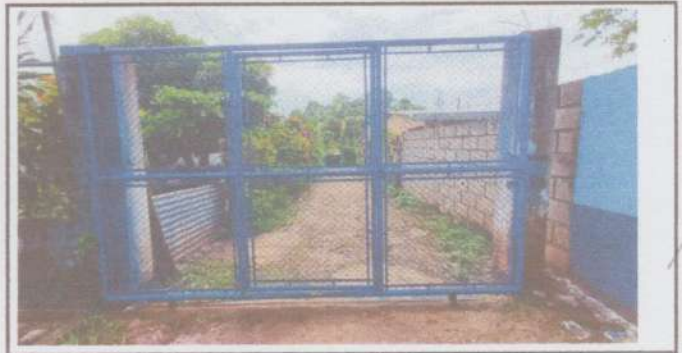
Foto 6: Mantenimiento a portón de metal. FINALIZADO.
