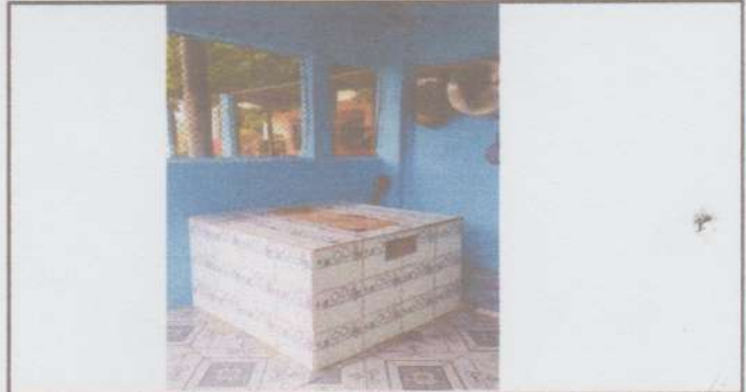
Foto 10: Reparación de estufa en cocina con ladrillo y chimenes. FINALIZADO.
