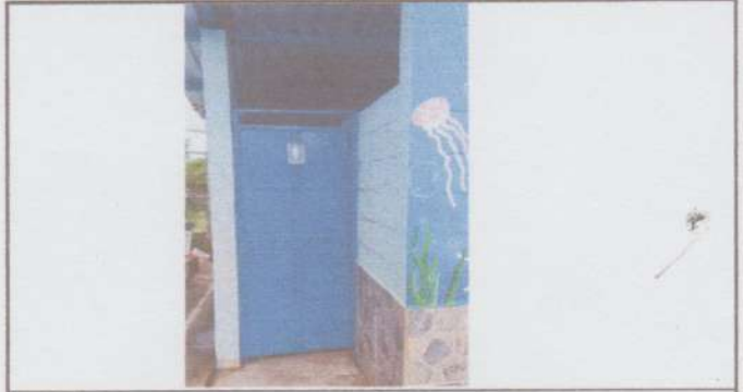
Foto 4: Mantenimiento a estructura de puerta (lijado, sepillado sujeciones, aplicación de pintura). FINALIZADO.
