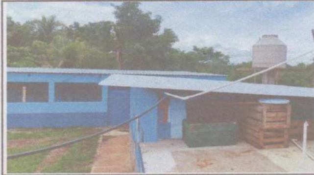
Foto1: Sustitución de lámina, por lámina troquelada Calibre 26. FINALIZADO.
