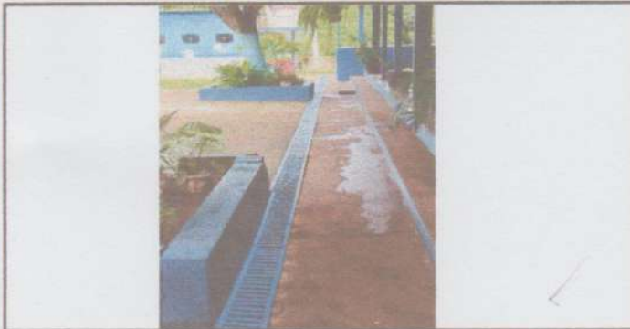
Foto 3: Sustitución de rejillas de metal para cunetas. FINALIZADO.
