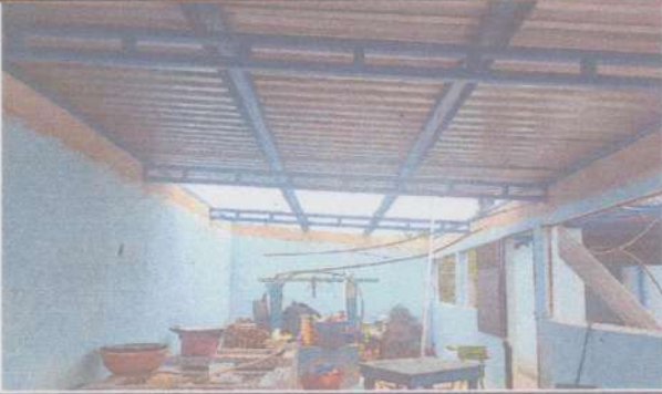
Foto 13: Mantenimiento de estructura de soporte (metal) por metal.
