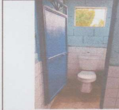
Foto 8: Sustrucción de accesorios inodoro (contra llave, tubo de abasto). FINALIZADO.
