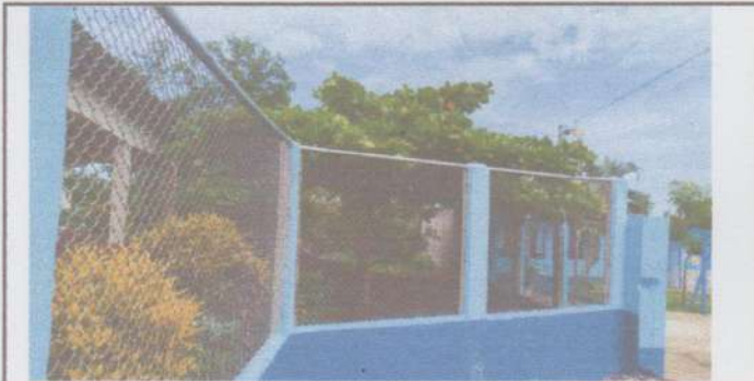
Foto 11: Sustrucción de muro perimetral con tubo HG y malla galvanizada. FINALIZADO.
