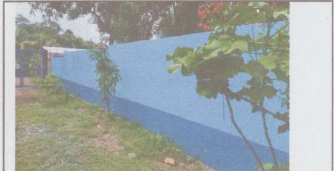
Foto 12: Reparación de muro perimetral (repello y cernido). FINALIZADO.
