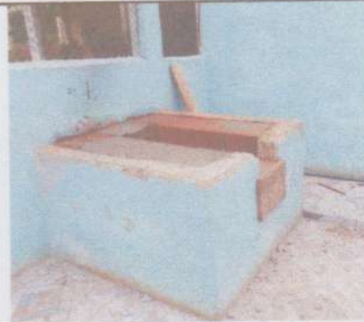
Foto 10: Reparación de estufa en cocina con ladrillo y chimenea.
