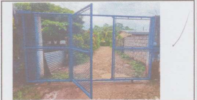
Foto 6: Mantenimiento a portón de metal.
