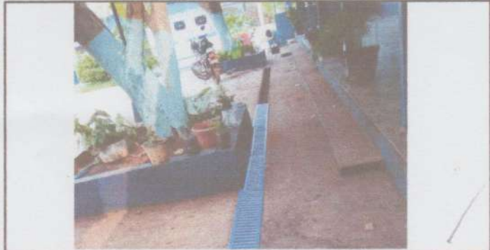
Foto 3: Sustitución de rejillas de metal para cunetas.
