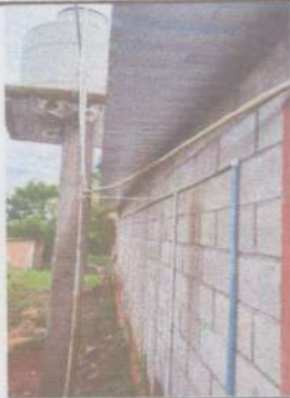
Foto 9: Sustitución de tubería PVC 1/2 Y 3/4 línea principal.
