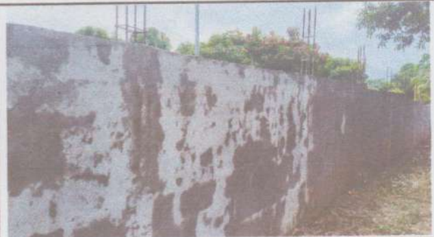
Foto 12: Reparación de muro perimetral (repello y cernido).
