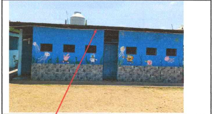
Mantenimiento a estructura de soporte de metal con anticorrosivo.
