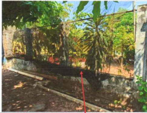
Sustitución de muro perimetral con tubo HG y malla galvanizada.
