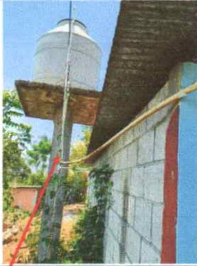
Sustitución de tubería PVC 1/2 y 3/4 línea principal.
