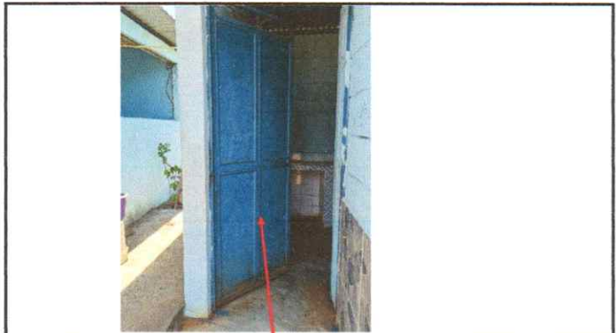
Mantenimiento a estrucutra de puertas (Lijado, cepillado, sujeciones, aplicaci3n de pintura).
