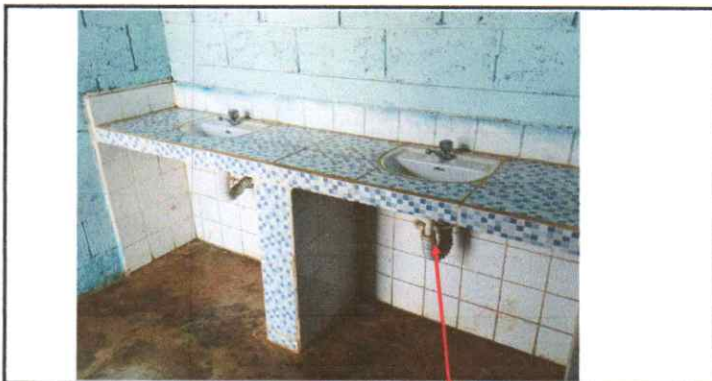
Sustitución de mezcladora lavamanos (Llave, contra llave, tubo de abasto)
