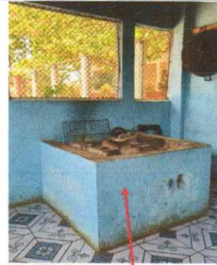
Reparación de estufa en cocina con ladrillo y chimenea.
