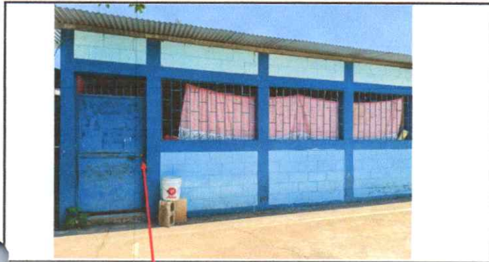
Sustitución de Chapa cerradura sobreponer de engrape.
