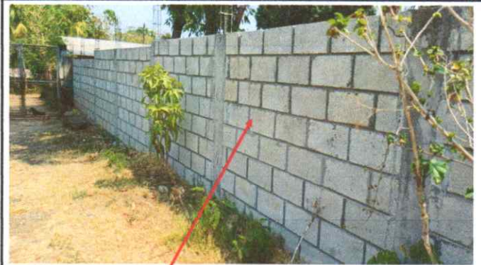
Reparación de muro perimetral (repello y cernido).
