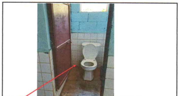
Sustitución de accesorios inodoro (contra llave, tubo de abasto)
