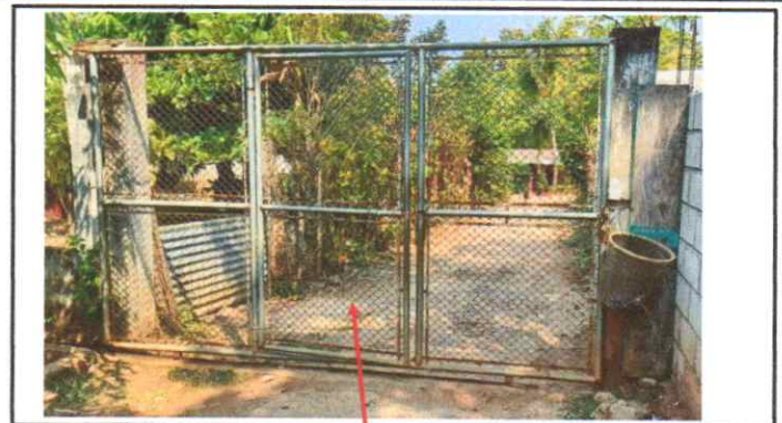
Mantenimiento a portón de metal.
