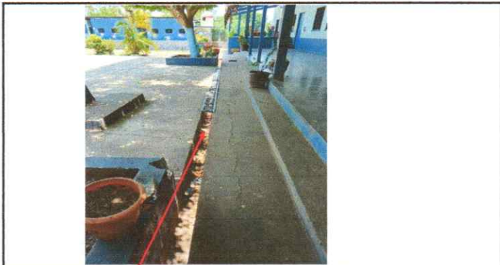
Sustitución de rejillas de metal para cunetas.
