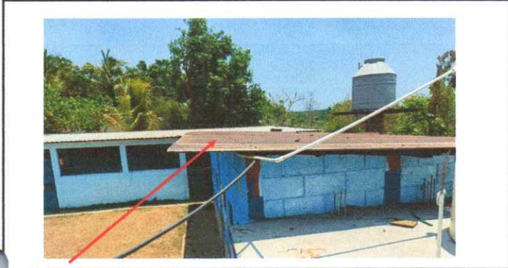
Sustitución de lámina, por lamina troquelada Calibre 26.
