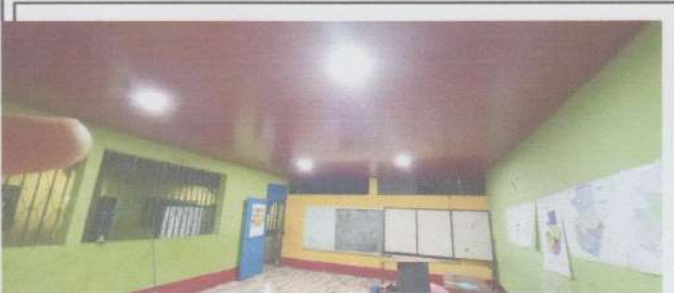
Foto 5: VISTA SUSTITUCIÓN DE MACHIMBRE POR CIELO DE PVC Y SUMINISTRO DE ENERGÍA ELECTRICA E INSTALACIÓN DE LAMPARAS OJO DE BUEY FINALIZADO
