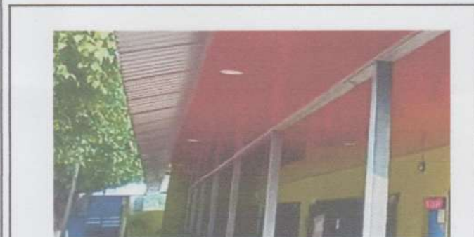
Foto 3: VISTA SUSTITUCIÓN DE MACHIMBRE POR CIELO DE PVC Y SUMINISTRO DE ENERGÍA ELECTRICA E INSTALACIÓN DE LAMPARAS OJO DE BUEY FINALIZADO
