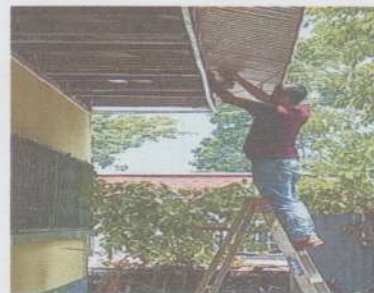
Foto 6: INSTALACIÓN DE PERFILERÍA PARA CIELO DE PVC
