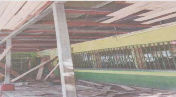
Foto 3: DESMONTAJE DE MACHIMBRE ANTIGUO
