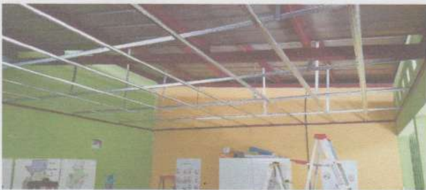
Foto 5: INSTALACIÓN DE PERFILERIA PARA CIELO DE PVC
