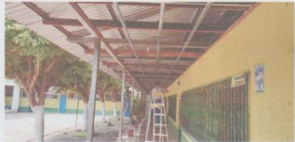
Foto 4: INSTALACIÓN DE PERFILERIA PARA CIELO PVC
