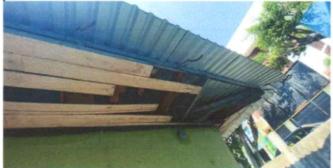
Sustitución de machimbre de madera por PVC
