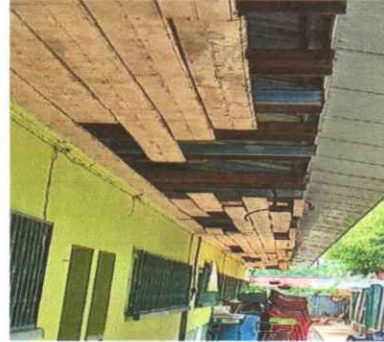
Sustitución de machimbre de madera por PVC
