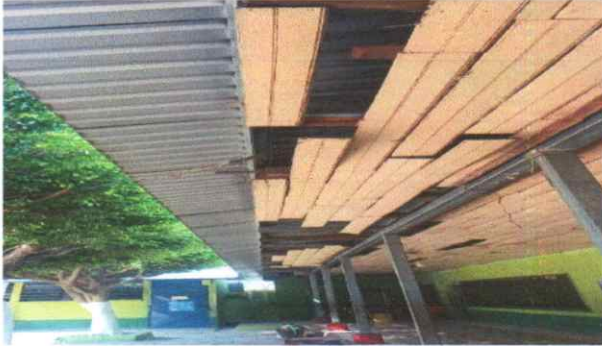
Sustitución de machimbre de madera por PVC
