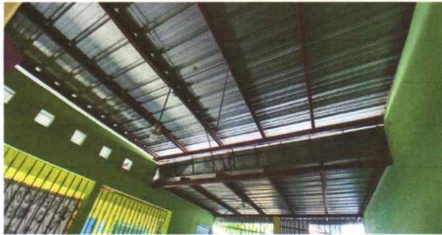
Sustitución de machimbre de madera por PVC
