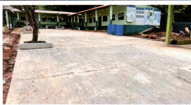
Foto 9: Se ha concluido con el mejoramiento de piso de torta de concreto en patio.
