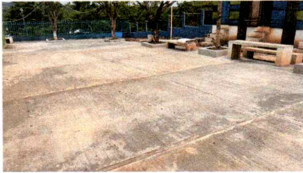
Foto 7: Se puede verificar el mejoramiento de piso de torta de concreto en patio.
