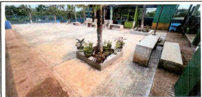
Foto 6: Se puede verificar el mejoramiento de piso de torta de concreto en patio.
