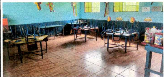
Foto 4: Se verifica la instalación de piso en aula 1, finalizada.
