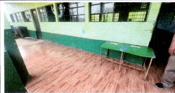
Foto 3: Se verifica la instalación de piso en área de corredor de módulo de aulas.
