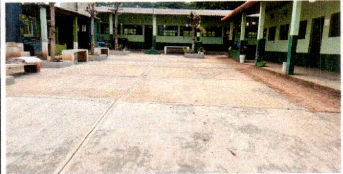
Foto 8: Se puede verificar el mejoramiento de piso de torta de concreto en patio, finalizado.
