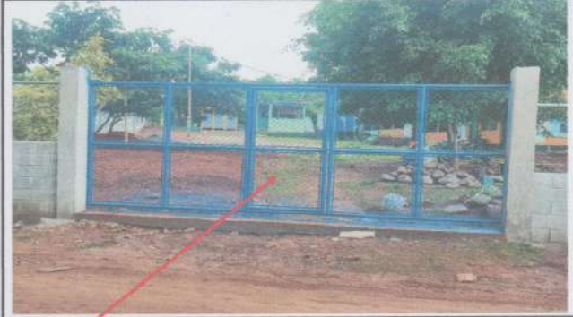
Suministro y sustitución de portón principal de tubos y malla galvanizada.
