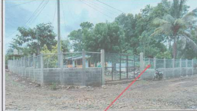
Suministro y sustitución de muro perimetral de block con tubo hg y malla galvanizada, soleras intermedias y columnas.
