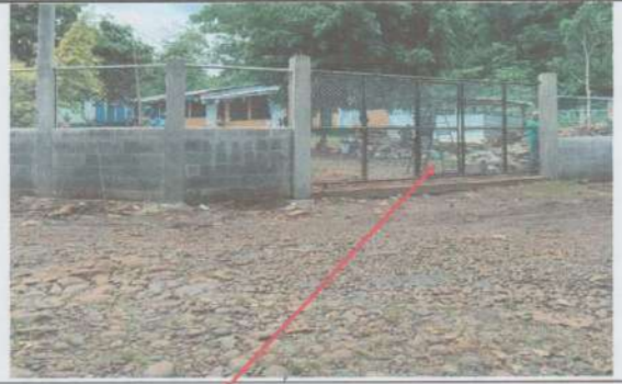
Suministro y sustitución de portón principal de tubos y malla galvanizada.
