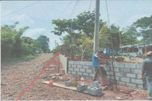
Suministro y sustitución de muro perimetral de block con tubo hg y malla galvanizada, soleras intermedias y columnas.
