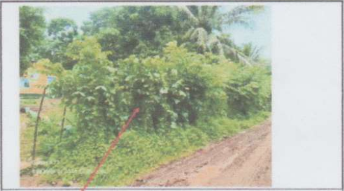
Suministro y sustitución de muro perimetral de block con tubo hg y malla gal
