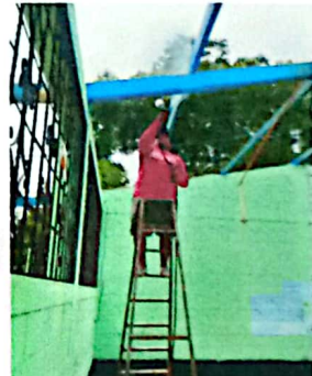
Foto 4: MANTENIMIENTO A ESTRUCTURA DE METAL DE TECHO CON PINTURA ANTICORROSIVO
