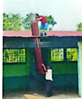
Foto 2: DESMONTAJE DE LAMINA EN MAL ESTADO
