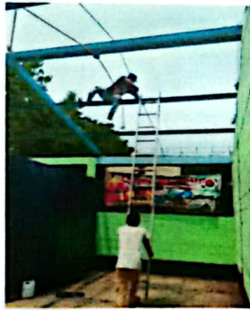
Foto 3: MANTENIMIENTO A ESTRUCTURA DE METAL DE TECHO CON PINTURA ANTICORROSIVO
