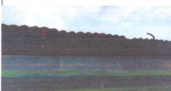
SUSTITUCION DE LAMINA, POR LAMINA MAXALUM CALIBRE 26
