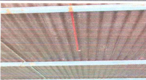
SUSTITUCION DE LAMINA, POR LAMINA MAXALUM CALIBRE 26
