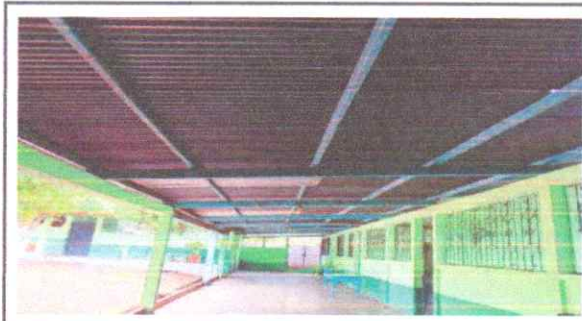
SUSTITUCION DE LAMINA, POR LAMINA MAXALUM CALIBRE 26
