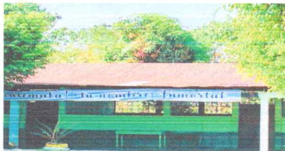
SUSTITUCION DE LAMINA, POR LAMINA MAXALUM CALIBRE 26
