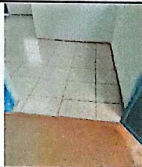
Foto 6: SUSTITUCION DE PISO TORTA DE CONCRETO Y PISO CERAMICO FINALIZADO
