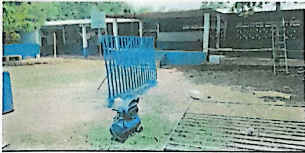
Foto 3: TRABAJO EN LA ELABORACION DE BALCONES
