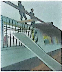
Foto1: TRABAJO EN LA SUSTITUCION DE ESTRUCTURA DE METAL
