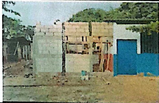
Foto 6: ELABORACION DE PARED DE CONCRETO
