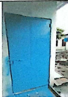
Foto 2: SUSTITUCION DE PUERTA DE METAL
