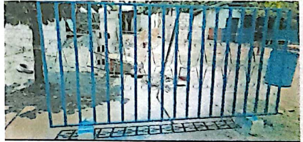
Foto 4: TRABAJO EN LA ELABORACION DE BALCONES
