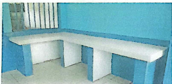
Foto 3: APLICACIÓN DE PINTURA EN MUROS INTERIORES
