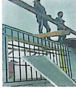
Foto 2: TRABAJO EN LA SUSTITUCION DE LAMINA
