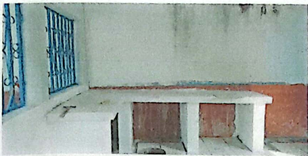
Foto 5: REPARACION DE MESA DE TRABAJO
