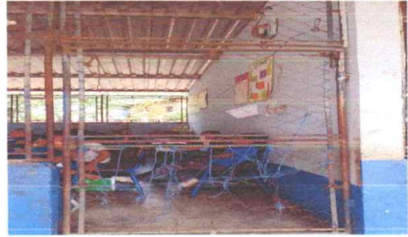
Sustitucion de puertas metalicas
