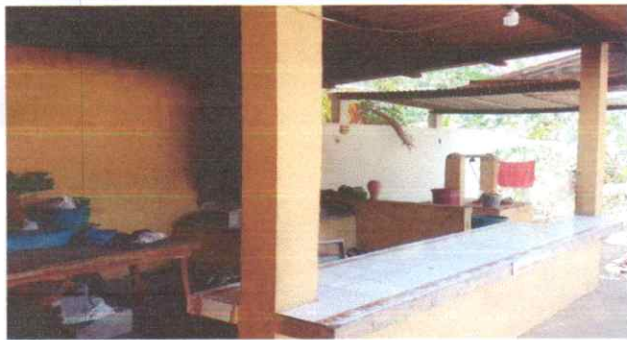
Reparacion de estufa en cocina con ladrillo y chimenea
