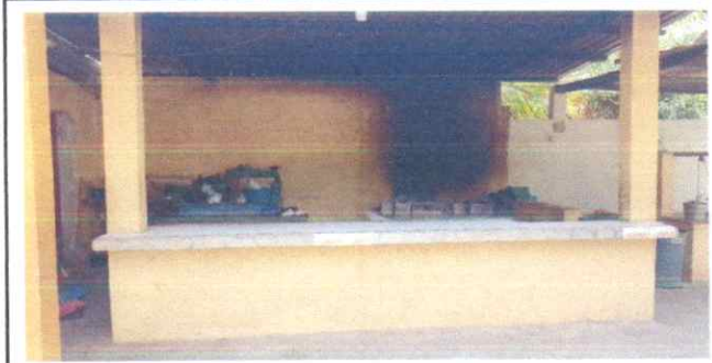
sustitucion de azulejo en cocina
