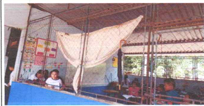
Sustitución de balcones
