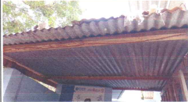
Sustitución de lamina por lamina troquelada aluzinc calibre 26
