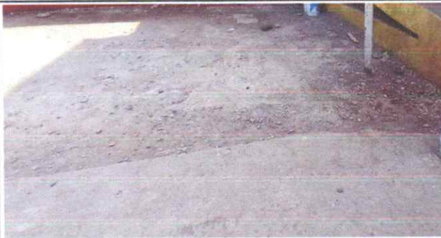
sustitucion de piso de torta de concreto por piso ceramico
