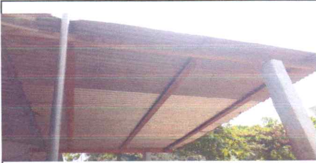
Sustitucion estructura de soporte madera por estructura metalica
