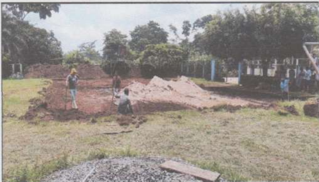
Foto1: Sustitución de piso de torta de concreto
