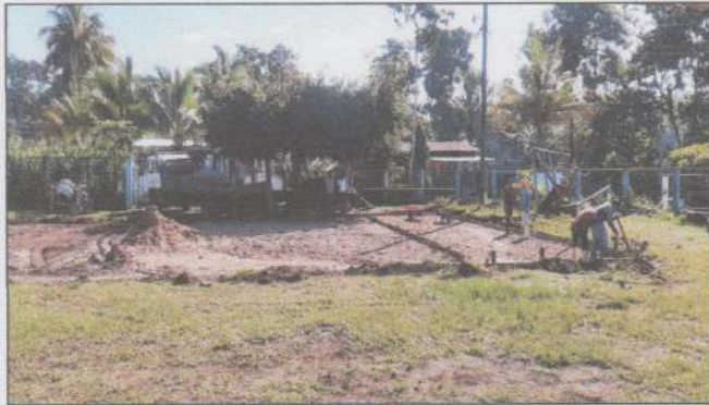
Foto 3: Sustitución de piso de torta de concreto
