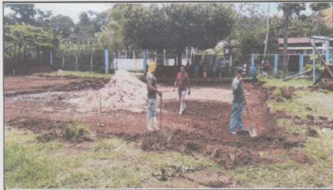
Foto 2: Sustitución de piso de torta de concreto
