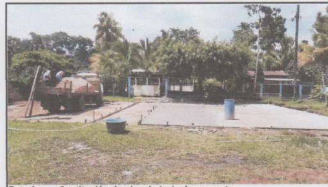
Foto 6: Sustitución de piso de torta de concreto
