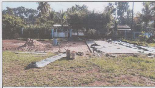
Foto 5: Sustitución de piso de torta de concreto
