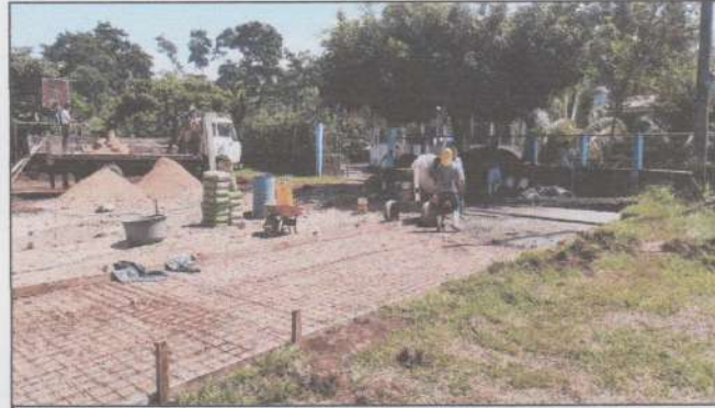
Foto 4: Sustitución de piso de torta de concreto
