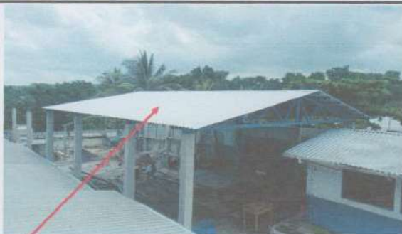
Suministro y sustitución de lámina, por lamina troquelada Calibre 26.
