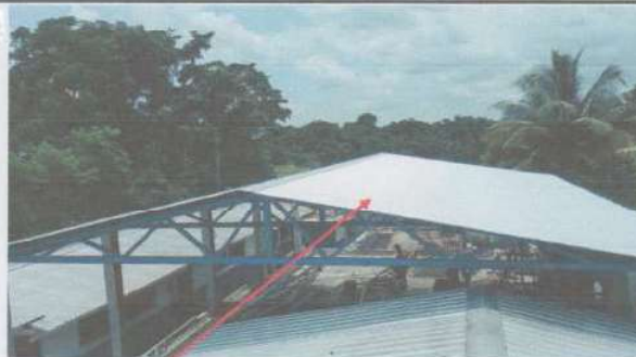
Suministro y sustitución de lámina, por lamina troquelada Calibre 26.
