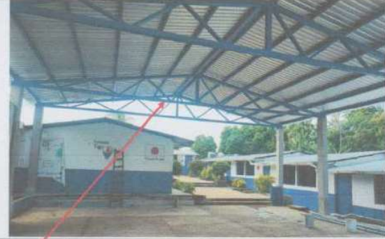
Suministro y sustitución de estructura de soporte (madera, metal) por metal
