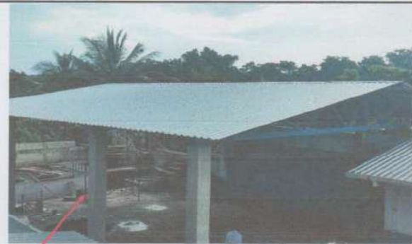
Suministro y sustitución de soporte de metal por Columnas de 0.30x0.30x6.0m Hierro legítimo 1/2", 3/8" y estribos 1/4".
