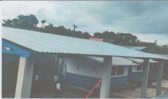
Suministro y sustitución de soporte de metal por Columnas de 0.30x0.30x6.0m Hierro legítimo 1/2", 3/8" y estribos 1/4".
