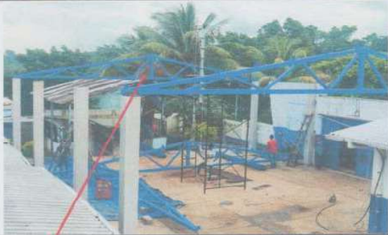
Suministro y sustitución de estructura de soporte (madera, metal) por metal.
