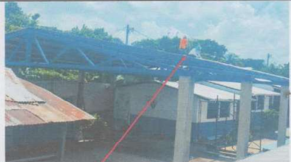
Suministro y sustitución de estructura de soporte (madera, metal) por metal.
