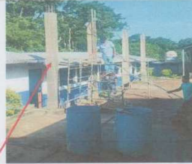
Suministro y sustitución de soporte de metal por Columnas de 0.30x0.30x6.0m Hierro legítimo 1/2", 3/8" y estribos 1/4".
