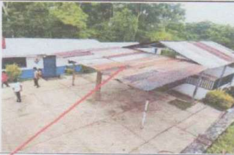
Suministro y sustitución de lámina, por lamina troquelada Calibre 26.
