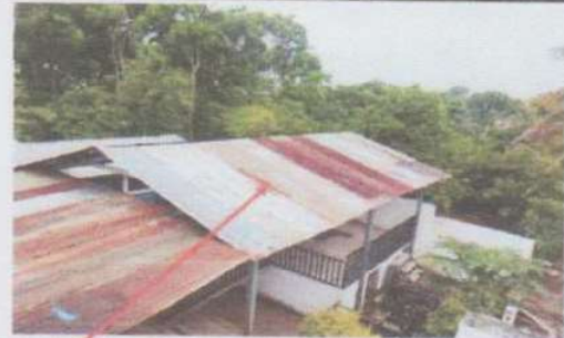
Suministro y sustitución de lámina, por lamina troquelada Calibre 26.
