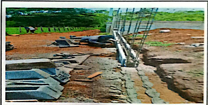
Foto 4: EMPIEZAN A PEGAR BLOCK
