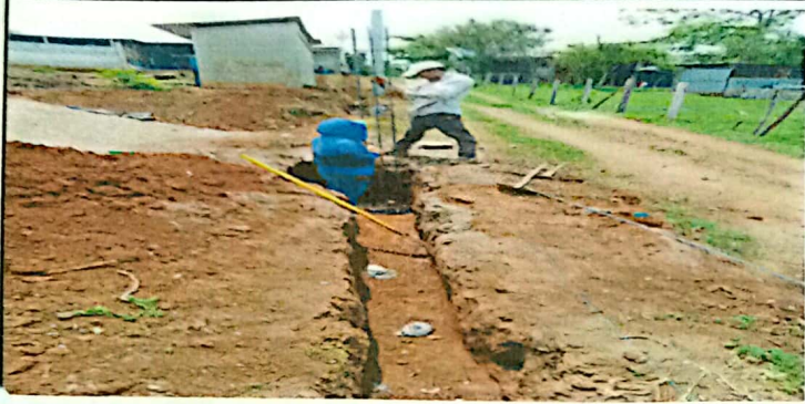
FOTO 1 SANJEADO PARA MURO
