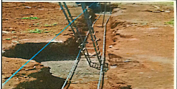
Foto 2: FUNDICION DE ZAPATAS
