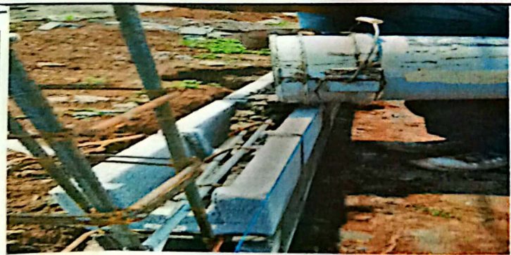
Foto 5: FUNDICION DE BLOCK U
