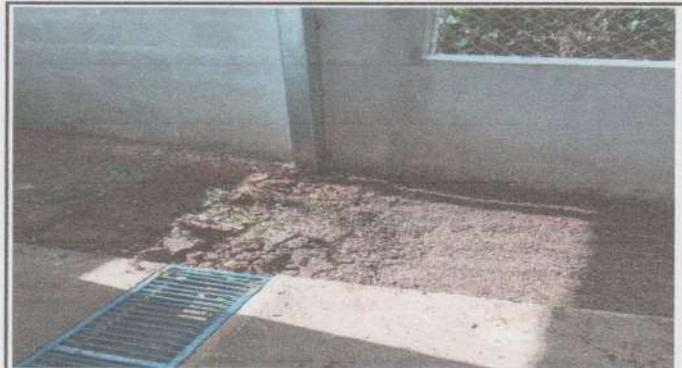
Sustitución de piso de torta de concreto
