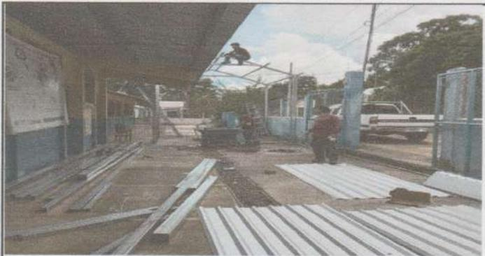
Sustitución de lámina, por lámina troquelada calibre 26 instalación de capotes de aluzinc liso de 2,20 c/u calibre 26
