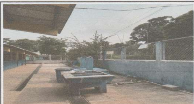
Sustitución de lámina, por lámina troquelada calibre 26 instalación de capotes de aluzinc liso de 2,20 c/u calibre 26
