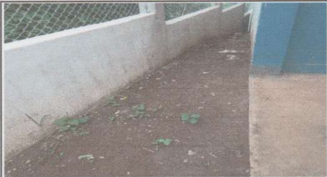
Sustitución de piso de torta de concreto
