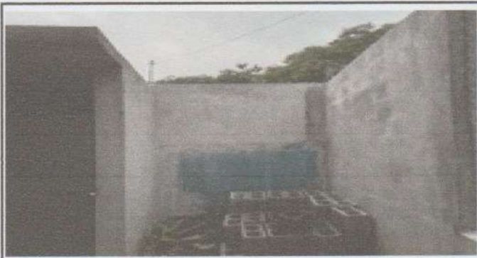
Sustitución de estructura de soporte (madera, metal) por metal.
