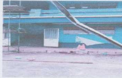
suministro e Instalacion de canal de Metal lado izquierdo y derecho
