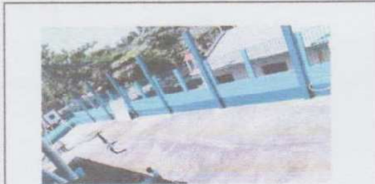
SUMINISTRO DE CANAL DE METAL LADO IZQUIERDO Y DERECHO
