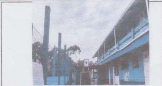
SUMINISTRO E INSTALACION DE ESTRUCTURA DE METAL
