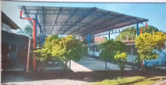
Foto 3: SUSTITUCION DE LAMINA POR LAMINA TROQUELADA CALIBRE 26
