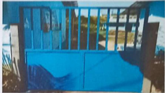
Foto 2: SUSTITUCION DE PORTON DE METAL
