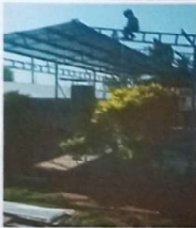
Foto 3: SUSTITUCION DE LAMINA POR LAMINA TROQUELADA CALIBRE 26
