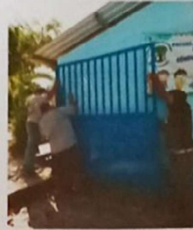
Foto 2: SUSTITUCION DE PORTON DE METAL
