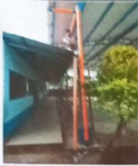
Foto 1: SUSTITUCION DE BAJADA DE PVC 4"
