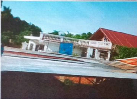
Foto 3: SUSTITUCION DE LAMINA POR LAMINA TROQUELADA CALIBRE 26
