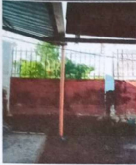
Foto 1: SUSTITUCION DE BAJADA DE PVC 4"
