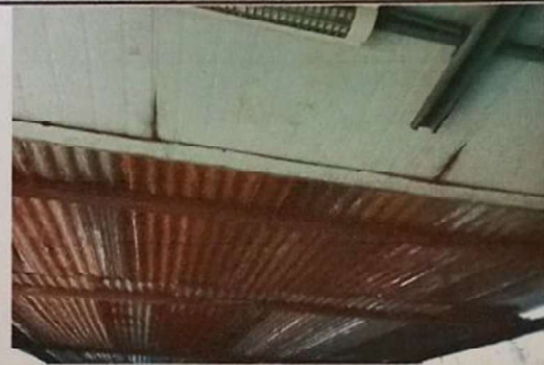
Foto 4: SUSTITUCION DE ESTRUCTURA DE SOPORTE POR ESTRUCTURA METALICA
