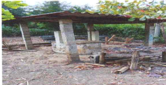
SUMINISTRO E INSTALCION DE TECHO PANELES , SUMINISTRO INSTALACION CIMENTACION
