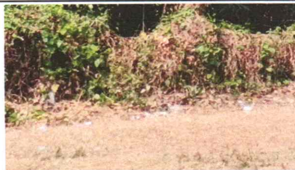
REPARACION DE CUNETETA DE CONCRETO
