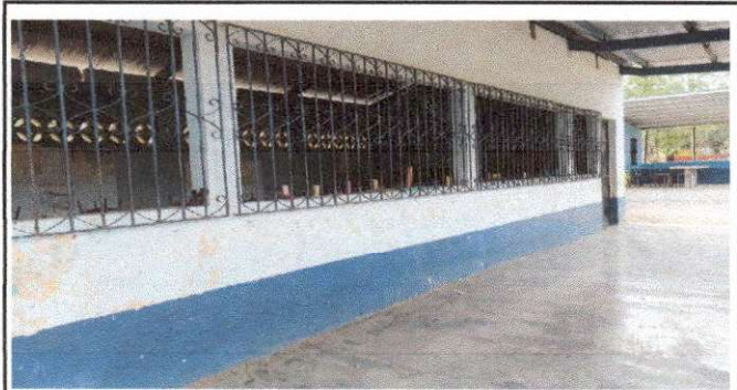
Foto 5: Estado de balcones de módulo 1
