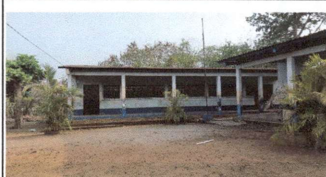
Foto 8: Estado exterior de módulo 2.
