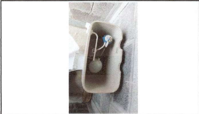
Foto 1: Estado actual de sanitarios.
