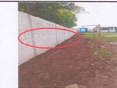
Foto 5: SUSTITUCIÓN Y REPARACION MURO PERIMETRAL, 150 M2
