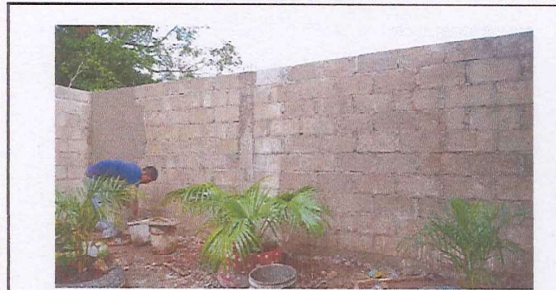
Foto 3: SUSTITUCIÓN Y REPARACION MURO PERIMETRAL
