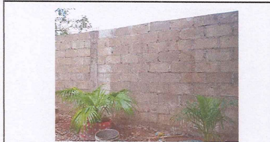
Foto 1: SUSTITUCIÓN Y REPARACION MURO PERIMETRAL
