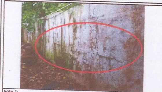
Foto 1: SUMINISTRO Y REPARACION MURO PERIMETRAL
