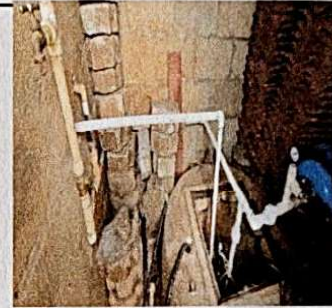
Foto 4: SUMINISTRO E INSTALACION BOMBA SUMERGIBLE 1/2 HP, TUBERIA 1" GALVANIZADA
