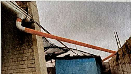
Foto 1: Suministro y sustitución de bajada pluvial
