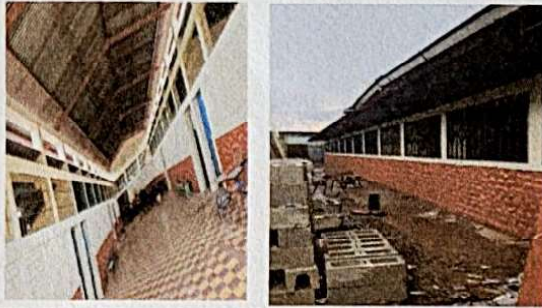
Foto 1: SUMINISTRO Y APLICACIÓN DE PINTURA EN MUROS EXTERIORES
