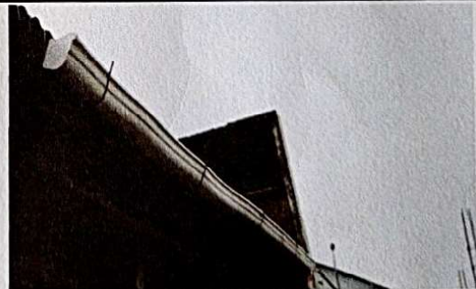
Foto 6: SUMINISTRO Y SUSTITUCION DE CANAL DE METAL
