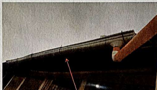
Foto 2: Suministro y sustitución de soporte de metal para canal
