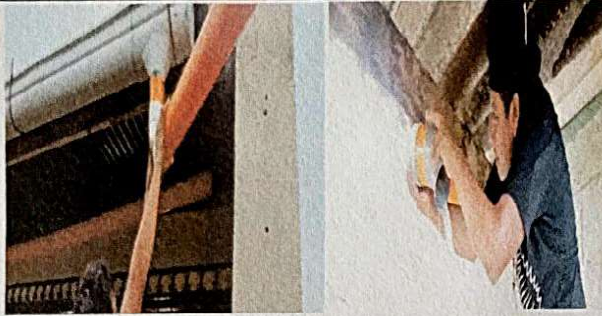
Foto 1: Suministro y sustitucion de bajada pluvial
