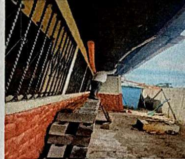
Foto 2: Suministro y sustitucion de soporte de metal para canal
