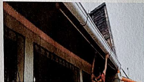
Foto 6: SUMINISTRO Y SUSTITUCION DE CANAL DE METAL
