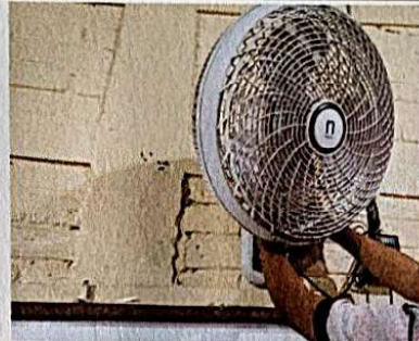
Foto 2: SUMINISTRO Y SUSTITUCION DE VENTILADOR 16"
