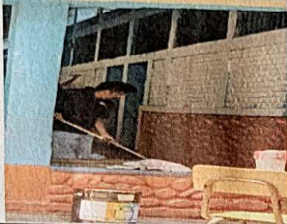
Foto 1: SUMINISTRO Y APLICACIÓN DE PINTURA EN MUROS EXTERIORES
