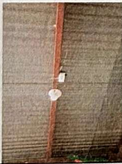
Foto 5: SUMINISTRO Y REPARACION SISTEMA ELECTRICO AULAS
