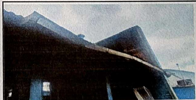
Foto 6: SUMINISTRO Y SUSTITUCION DE CANAL DE METAL
