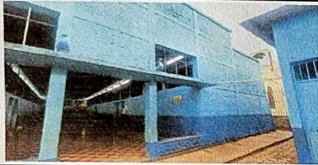
Foto 1: SUMINISTRO Y APLICACIÓN DE PINTURA EN MUROS EXTERIORES
