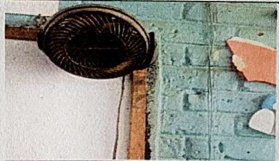
Foto 2: SUMINISTRO Y SUSTITUCION DE VENTILADOR 16"
