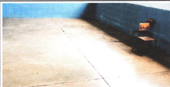
FOTO 7: Suministro e instalacion de piso ceramico aulas y cocina
