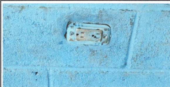
FOTO 8: Suministro e instalacion de sistema electrico
