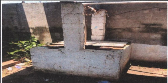
FOTO 4: Suministro y reparacion de brocal de pozo
