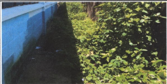
FOTO 9: Suministro y sustitucion de banqueta de concreto
