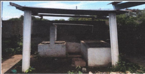
FOTO 1: Suministro y sustitucion de estructura metalica pozo
