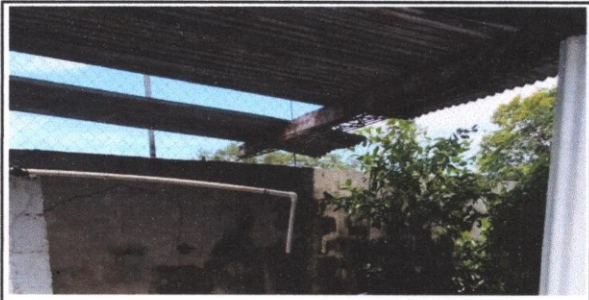
FOTO 2: suministro y sustitucion de lamina troquelada C26 pozo
