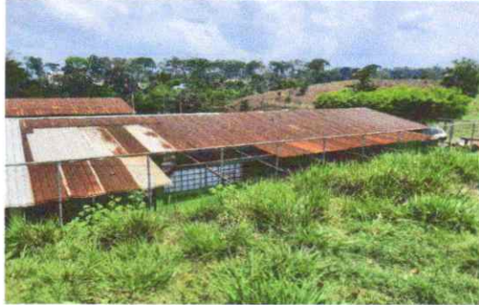
Foto 1: Cubierta de lámina
