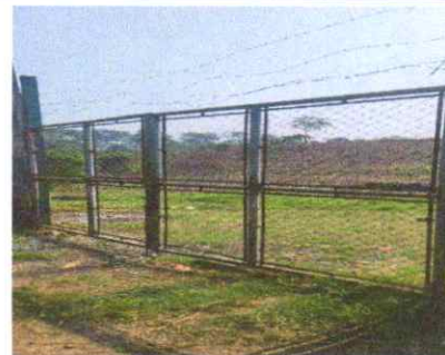
Foto 6: Mantenimiento a portones
