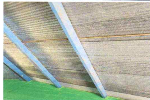
Foto 2: Estructura de techo
