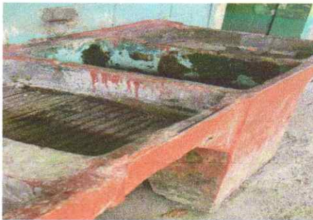
Foto 3: sustitución de pila
