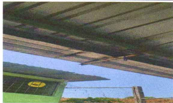
Foto 4: Canales y bajadas de agua pluvial
