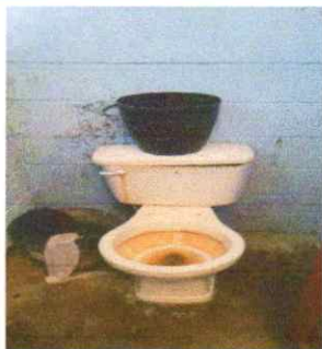
Foto 5: Sustitución de servicios sanitarios y sus accesorios
