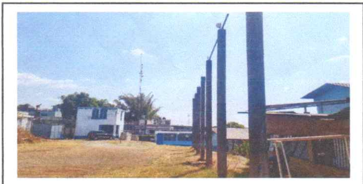
AMPLIACIÓN DE TECHADO
