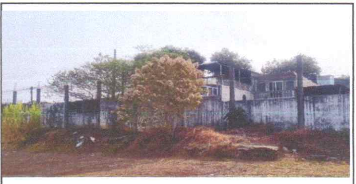
AMPLIACIÓN DE TECHADO
