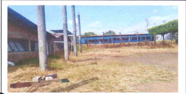
AMPLIACIÓN DE TECHADO
