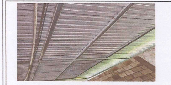
Foto 5: SUSTITUCIÓN DE ESTRUCTURA DE METAL DE SOPOTE DE TECHO
