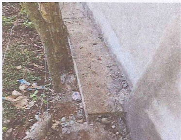
Foto 7: REPARACION DE BANQUETA DE CONCRETO
