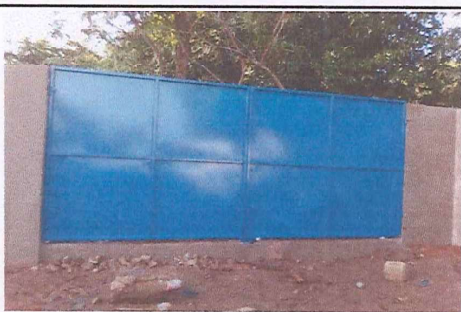
Foto 9: FABRICACIÓN E INSTALACION DE PORTON DE METAL
