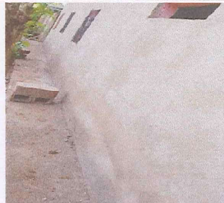
Foto 8: REPARACION DE BANQUETA DE CONCRETO
