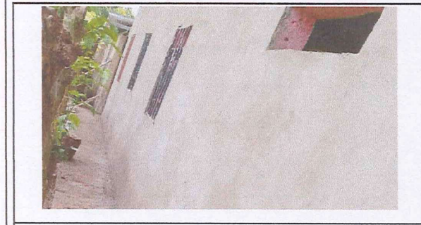
Foto 3: REPARACION DE PARED EN AULA, REPELLO Y CERNIDO CON CONCRETO
