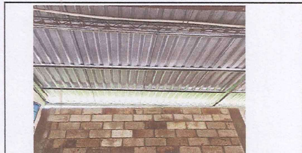
Foto 6: SUSTITUCIÓN DE LAMINA POR LAMINA TROQUELADA C26
