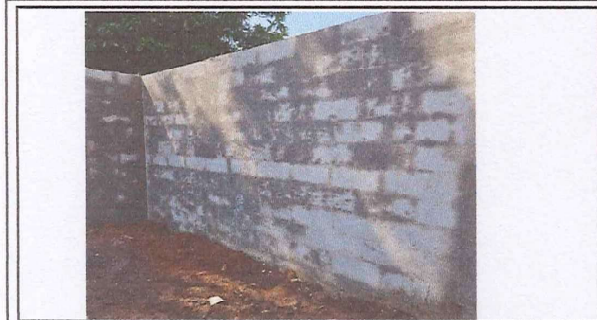
Foto 1: REPARACION Y SUSTITUCION DE MURO PERIMETRAL 72 METROS CUADRADOS
